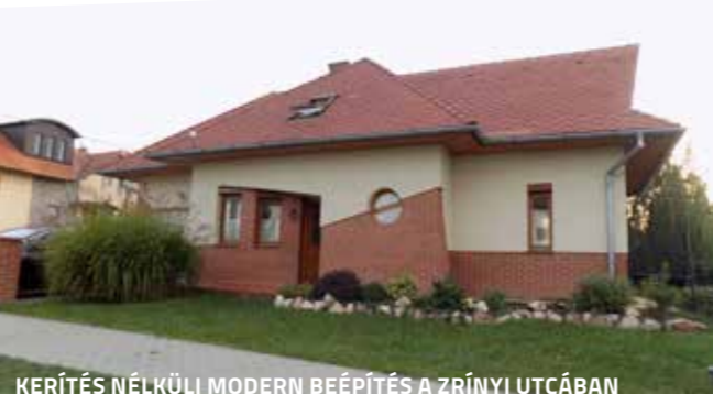
KERÍTÉS NÉLKÜLI MODERN BEÉPÍTÉS A ZRÍNYI UTCÁBAN
