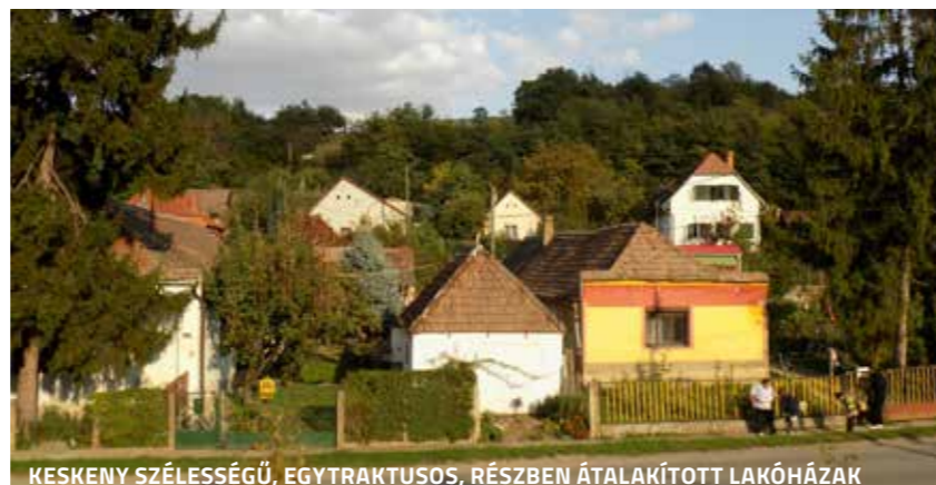
KESKENY SZÉLESSÉGŰ, EGYTRAKTUSOS, RÉSZBEN ÁTALAKÍTOTT LAKÓHÁZAK
